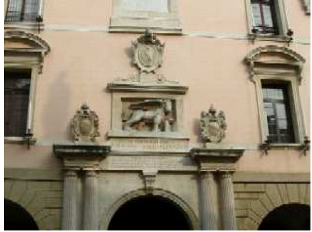
La facciata del nuovo palazzo del Bo, completato durante il dogado di Pasquale Cicogna (1585-95)
